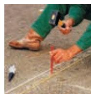
EN TERRENOS DUROS HACER UN HOYO CON UN BURIL
